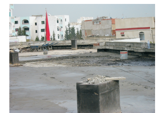
Reprise de l'étanchéité du terrasse
