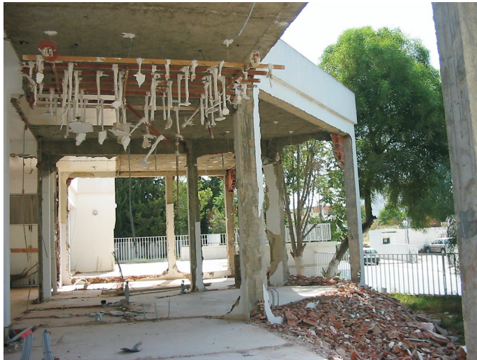
Bloc Administratif au cours des travaux
