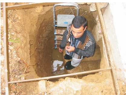
Sondage sur fondation postérieure
