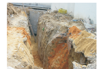
Drainage périphérique du bâtiment
