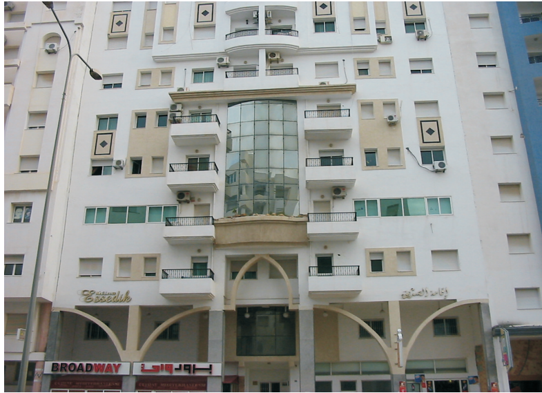
Façade Principale sur l'avenue Hédi Nouira
