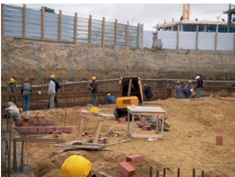
Travaux de fondation
