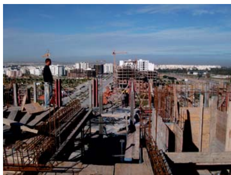
Travaux en étage
