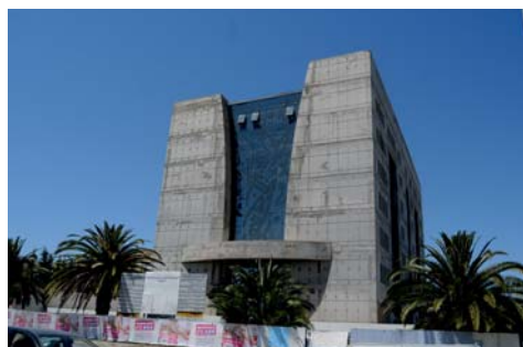
Vue sur Façade principale en 12/2014
