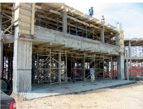
Décoffrage du PH 1er Etage
