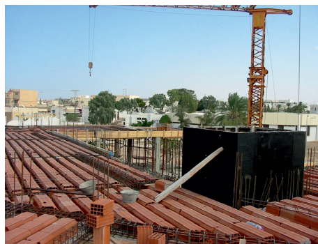
Pose de Ferrailage
