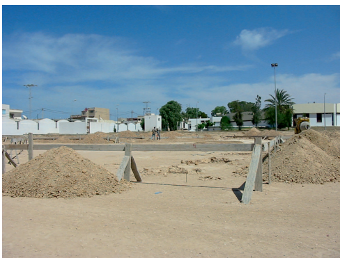
Implantation des axes
