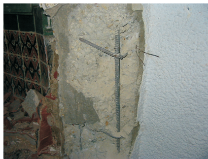
Sondage au niveau du poteau
