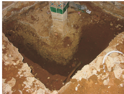
Sondage au niveau de la fondation
