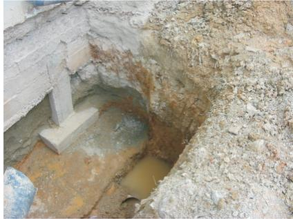
Sondage ponctuel au niveau d'une semelle : localisation de fuite d'eau au niveau du gros béton
