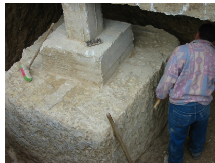
Fondation: Reprise en sous oeuvre
