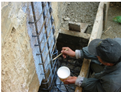
Poteaux: Confortement par chemisage
