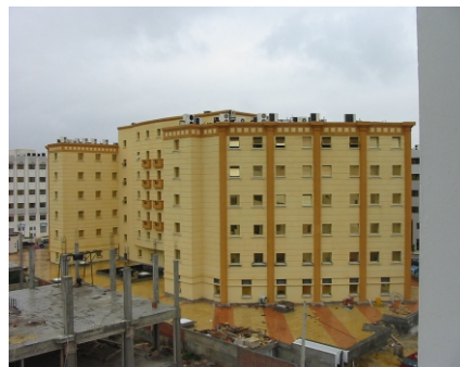
Vue extérieure de la façade Ouest
