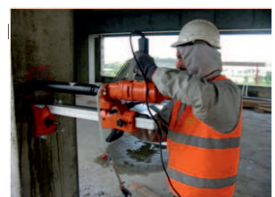
Fixation de l'appareil et opération de carottage
