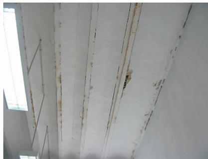
Poutrelles métalliques du plancher corrodées
